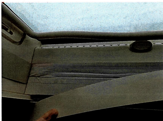
-brak laminowania krawędzi elementów drewnianych
