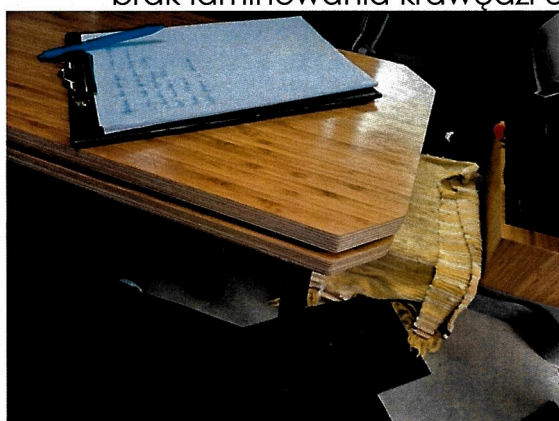
-brak laminowania krawędzi elementów drewnianych
