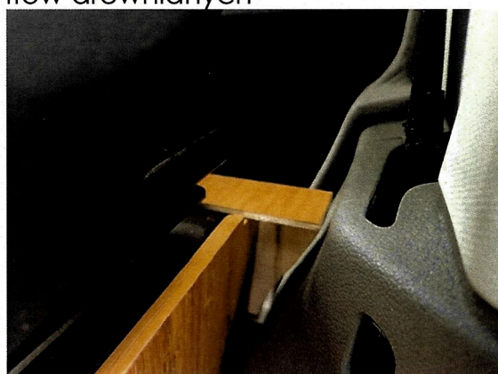
-brak laminowania krawędzi elementów drewnianych
